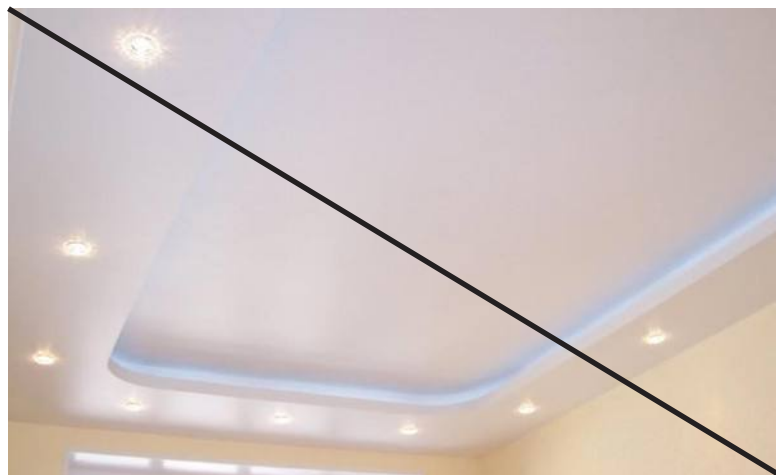
Плохо Многоуровневые гипсокартонные конструкции
