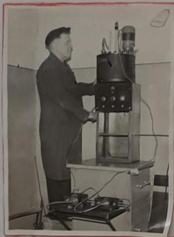
Стенд для регулировки термореле
